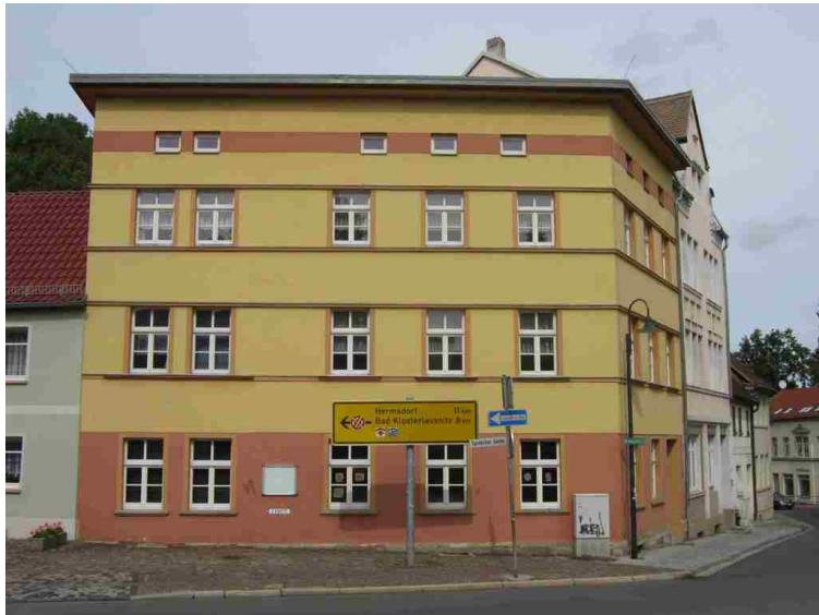
Seitenansicht des Hauses JBG Ziegelgasse 7
